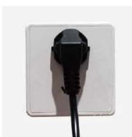
При соединении через штепсельную вилку, гнездо должно быть легко доступно во время работы и иметь возможность отключения в случае неисправности.
